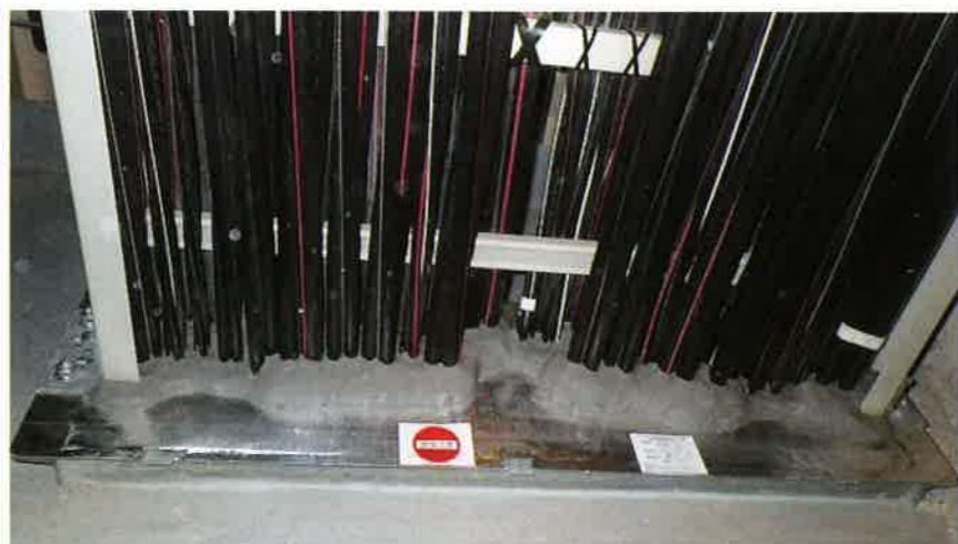
⑩ J-ボードと鋼製枠とのジョイントにALGCテープを用いて仕上げ、ラベル(認定・踏抜厳禁)を貼り完了です。
