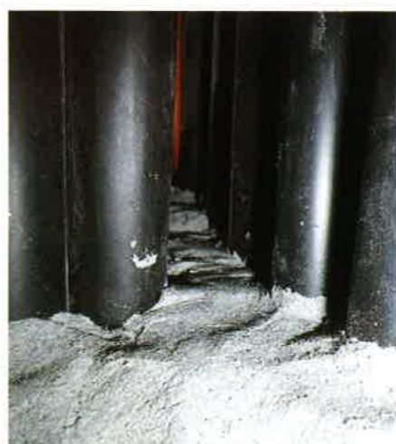
⑨ 両面ラックの子桁部分にも所定の高さのJ-パテを盛り上げます。
