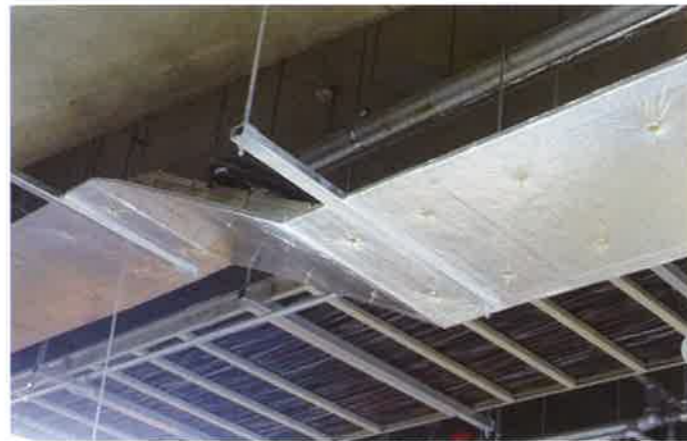
グラスウール仕様 ラック下遮へい処理 施工写真
