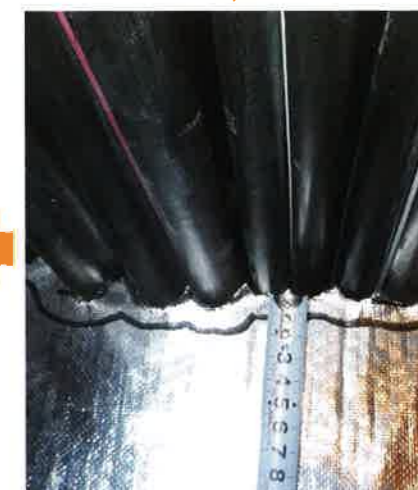
⑥ ケーブルとJ-ボードのパテ掛りしろ(10mm以上)の位置にマーキングをします。
