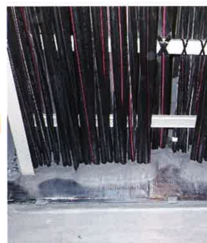
⑧ マーキング以上の量までJ-パテを盛り上げます。
