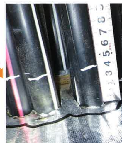
⑦ ケーブルにJ-パテの盛り高さの位置を示すマーキングをします。
