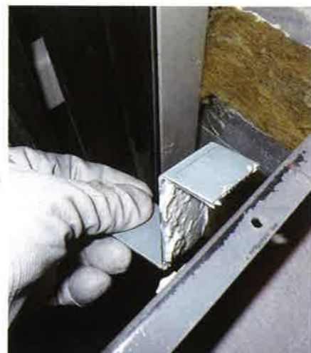
② 床置架台の下部に耐火接着剤を用いて、J-ボードを取付けます。支持金物を必要に応じて接着剤、両面テープにて開口フランジに取り付けます。
