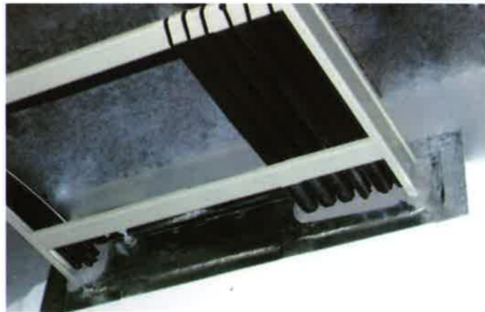
Jボード仕様 防煙処理 施工写真
